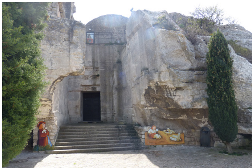
Entrée de l'ancienne citerne
